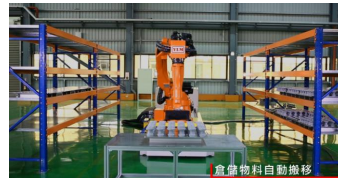
工研院自動化倉儲物料自動搬移
